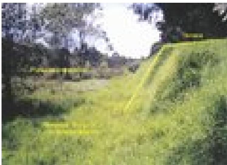
Figura 37. Terraza alta y talud con inclinación fuerte producto de relleno
