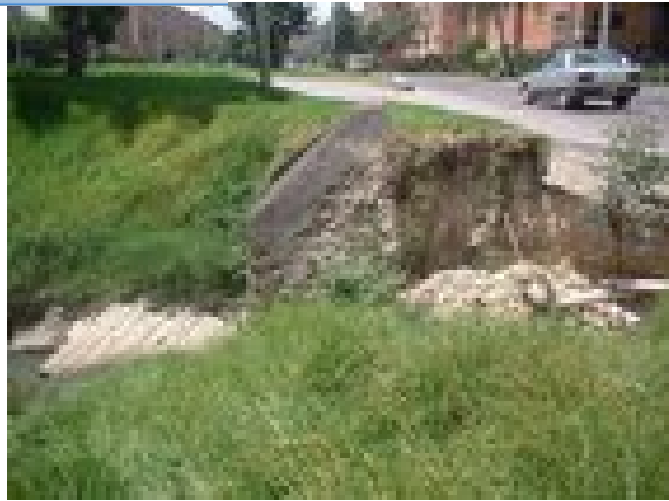
Figura 57. Falla en los taludes de Canal Córdoba
